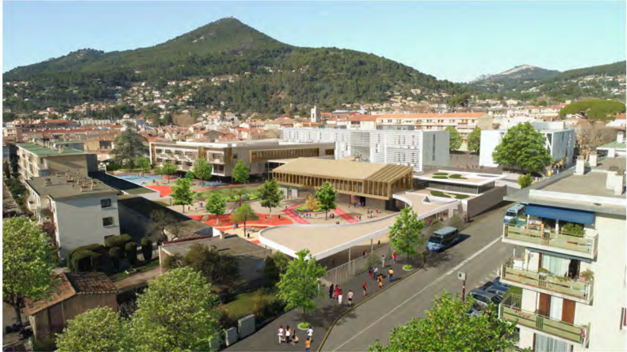
Vue aérienne de l'ensemble du projet.
